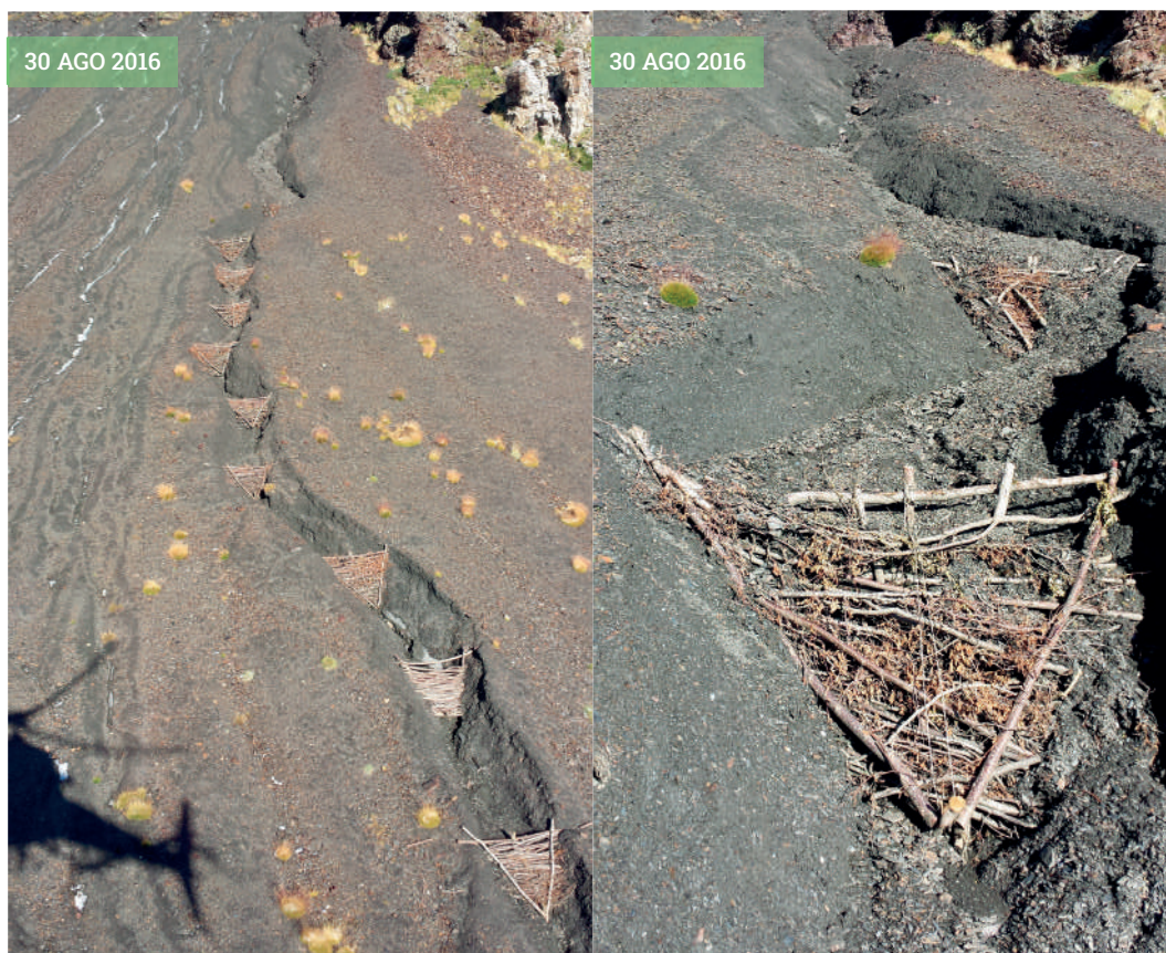
Figura 5: A izquierda cárcava con microdiques recién contruidos, obsérvese el suavizado cóncavo de la cárcava por pisoteo del ganado. A derecha retención de las primeras lavas torrenciales, obsérvese las paredes verticales y el cordón de desbordamiento que se forman al paso de las lavas.
